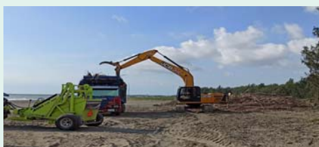
臺南黃金海岸蚵架清理作業情形
