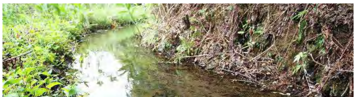
工區農路坍塌
