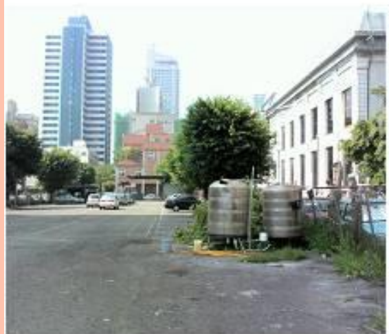
停車廠水塔無蓋
