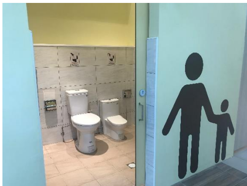
評定編號 1：每處廁所皆設置獨立親子友善廁所
