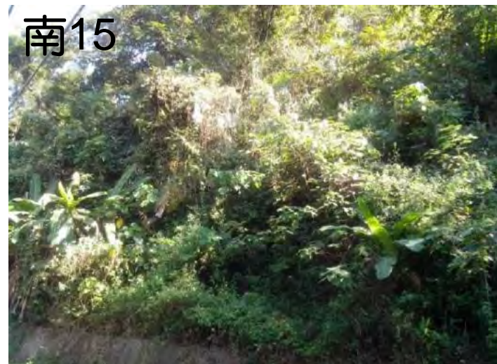
邊坡植生恢復良好，覆蓋率100%
