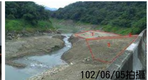
完工後已移除施工便道並回復地表狀況
